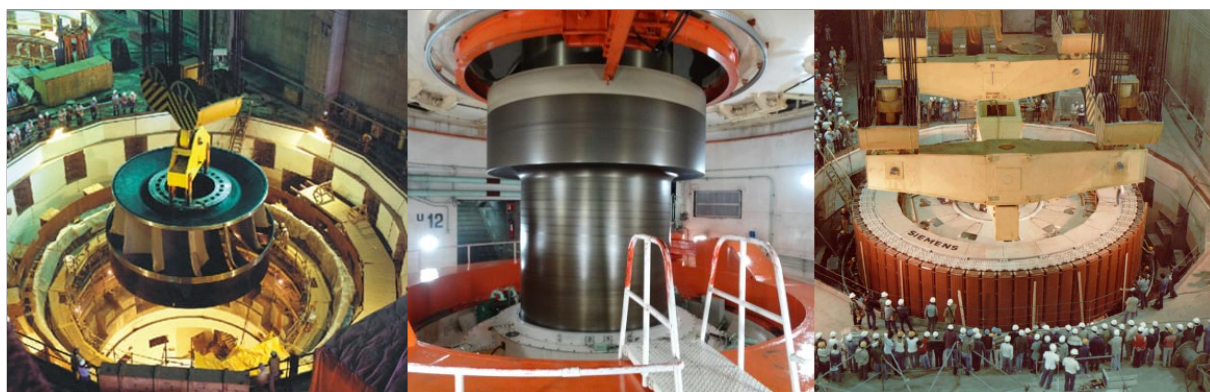
Figura 2.2: Turbina à esquerda, eixo ao centro e rotor à direita.
